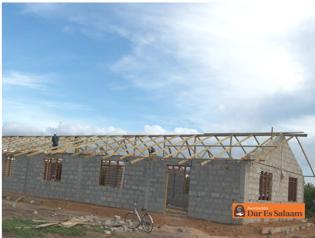
Foto de las obras del hogar Kind Heart.
